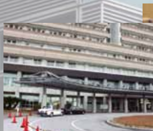
光を入れるためにガラス張りの構造になっている雨除け屋根
