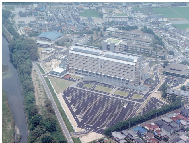
完成直後の新病院全景
