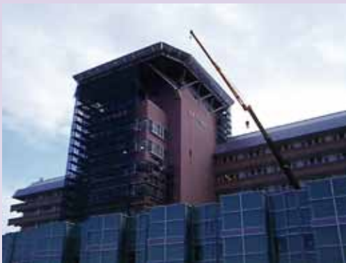
建築中の 新彦根市立病院
