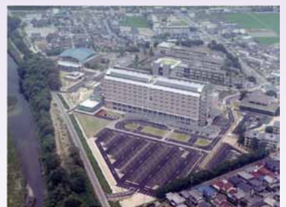
新病院の外観
